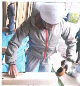
未来に繋ぐ技術の墨付け
